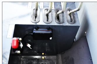
加装北斗定位模板，科技辅助作业，数据实时查看，科技引领农机作业。
